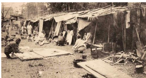
旭町（現新宿4丁目）の罹災状況
